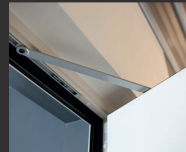
Im Türblatt verdeckter Türschließer mit Blockade
